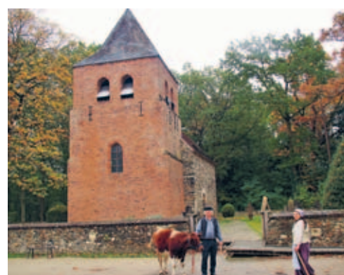
De kerk uit Erpekom (twaalfde eeuw) werd in 1959 afgebroken en in Bokrijk op basis van zesduizend foto's steen voor steen opgebouwd.
