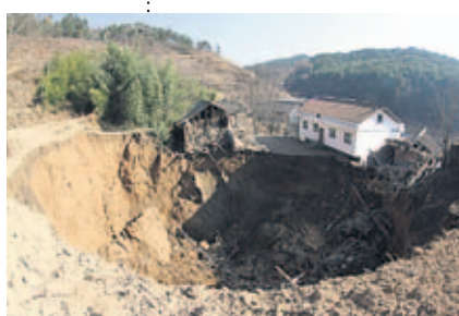
Een zinkgat onder het Chinese plaatsje Pingxi. In het gat van 60 bij 40 meter en een diepte van 30 meter zijn twaalf gebouwen verdwenen.
